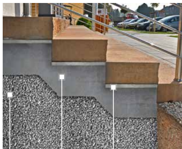
Podbudowa z kruszywa Fundament z chudego betonu ew. ok. 1 cm warstwa zaprawy cementowej
